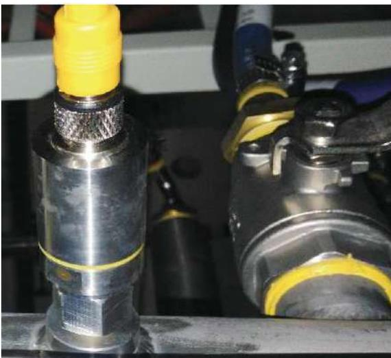
Los sensores de temperatura Ema detectan la temperatura de funcionamiento mediante un dispositivo PT1000 y a continuación transmite los datos a un circuito de procesamiento. Después del procesamiento, la temperatura de funcionamiento actual se muestra a través de un LED y se convierte automáticamente en una señal digital (NPN, PNP) o una señal analógica (0-10V, 4-20mA).
